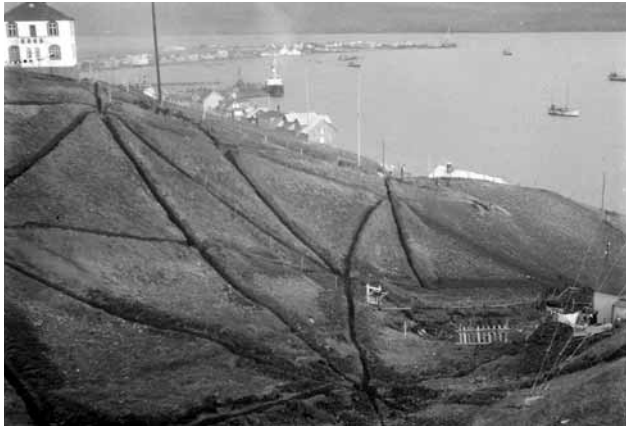
Jarðtenging loftneta mikilvæg, ákveðið kerfi – öðrum megin. (Mynd: Minjasafnið á Akureyri)
